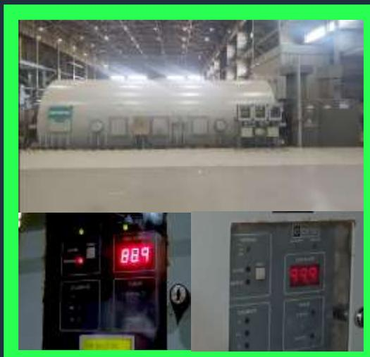
**Substituição do hidrogênio cinza pelo hidrogênio verde** do projeto piloto aumentou a pureza de 90% para 99,9%
