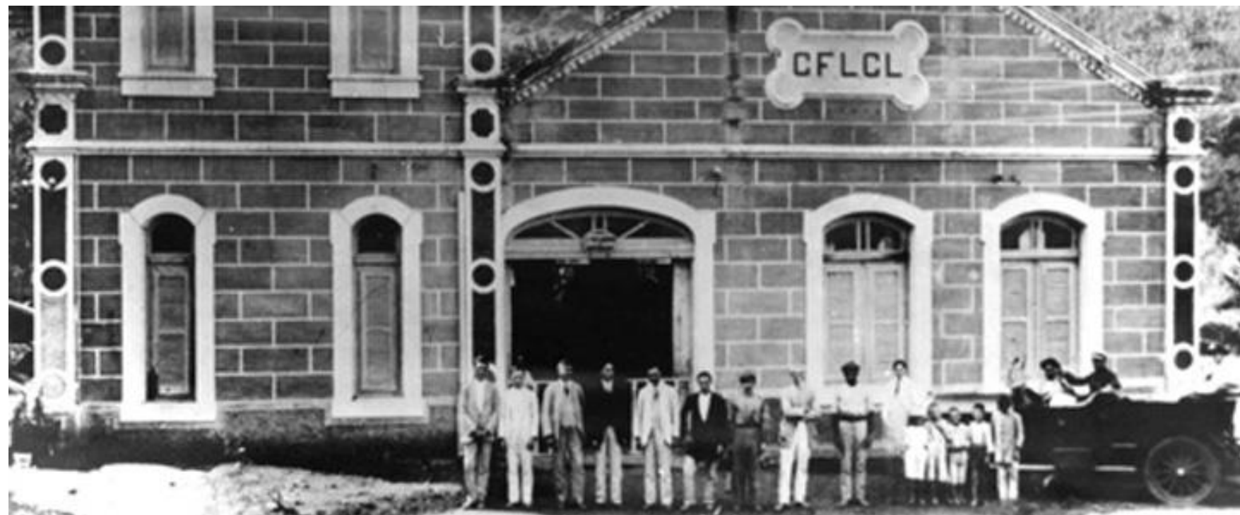
1908: A CFLCL inaugura sua primeira hidrelétrica, a Usina Maurício, com 800 kW de potência, uma das geradoras pioneiras do país.
