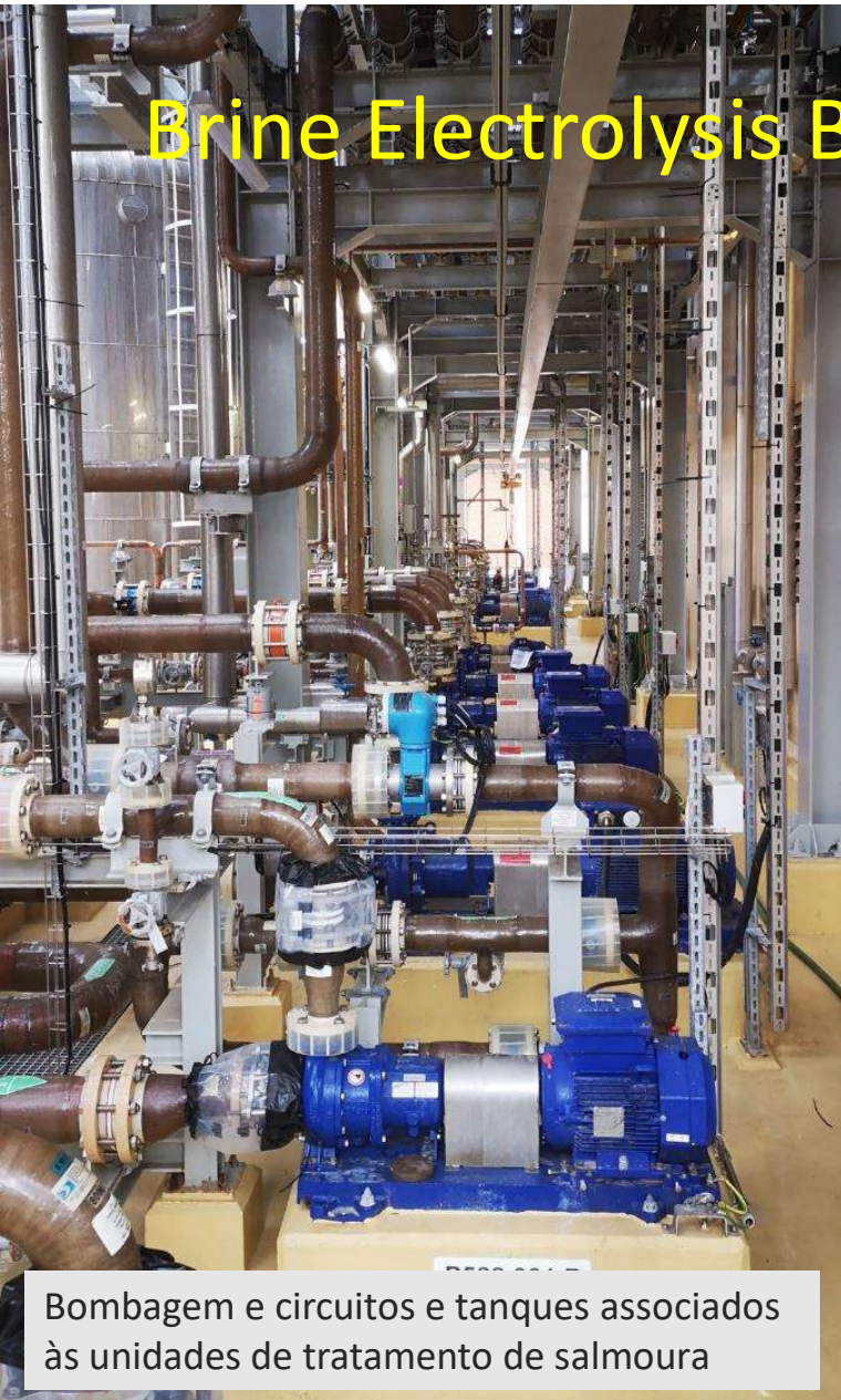
Bombagem, circuitos e tanques associados à circulação de eletrólitos da Eletrólise
