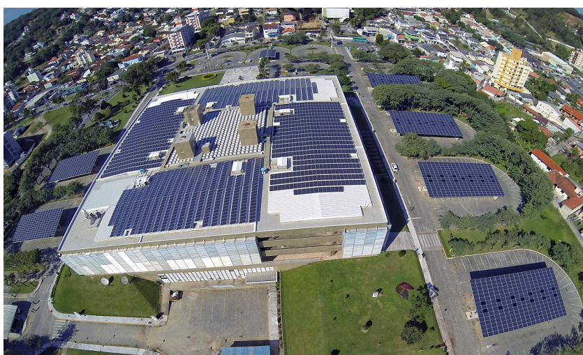
Figura 56. Edifício Sede da Eletrosul em Florianópolis-SC, com geradores solares fotovoltaicos integrados na cobertura do prédio e nos estacionamentos, somando 1 MWp de potência.
