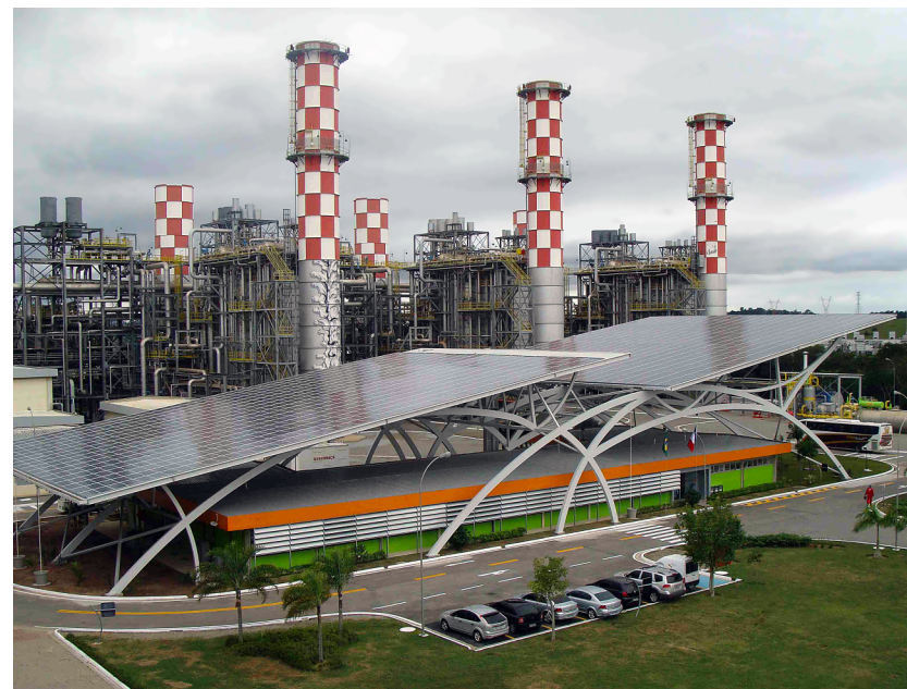
Figura 57. Integração de gerador solar fotovoltaico sobre a edificação administrativa da Usina Termoelétrica a Gás EDF Norte Fluminense, em Macaé-RJ, com 320 kWp de potência.
