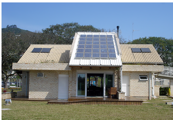
Figura 54. Casa Eficiente Eletrosul em Florianópolis-SC, com um gerador solar fotovoltaico de 2 kWp integrado em seção do telhado orientado para o norte verdadeiro e inclinado a 27 graus (equivalente à latitude de Florianópolis).
